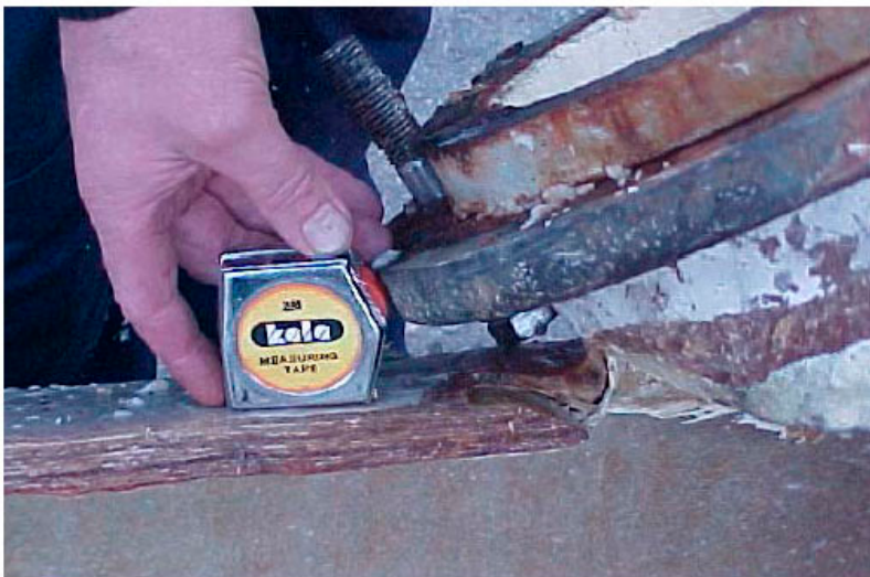
Bild 3. Stuts DN 250 med alltför kort byggmått
